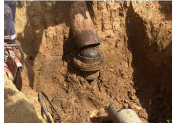
Boule de clapet logé dans le coude de la canalisation
